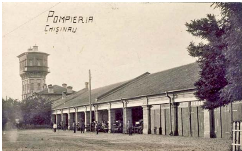
Fig. 2. Turnul de Apă și stația de pompieri din Chișinău.
