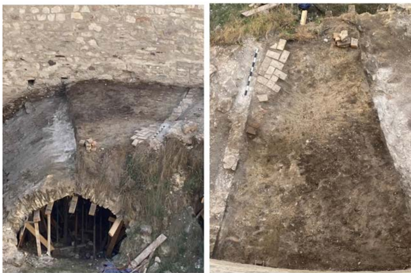
Fig. 2. Soroca 2023. Cazemata 5. Urme ale pardoseli din cărămidă
