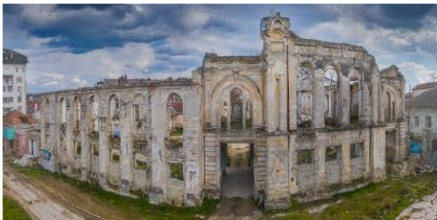
Рисунок 3. Фасад здания бывшей синагоги [5].
