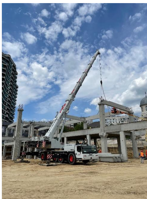
Figura 6. Construirea centrului comercial KAUF LAND din elemente prefabricate din beton armat or. Chișinău
